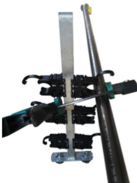
Insertion du tube à l'aide du serre-joint
